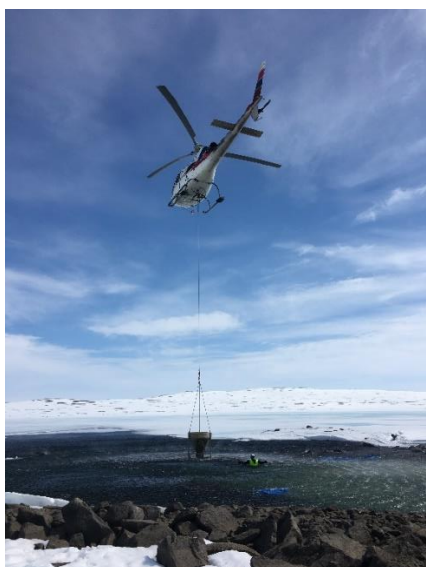
Utlekking av grus med helikopter. Det ble kjørt ut ca 900 kg i hvert løft. Grusen ble fordelt av personell fra LFI Bergen.
